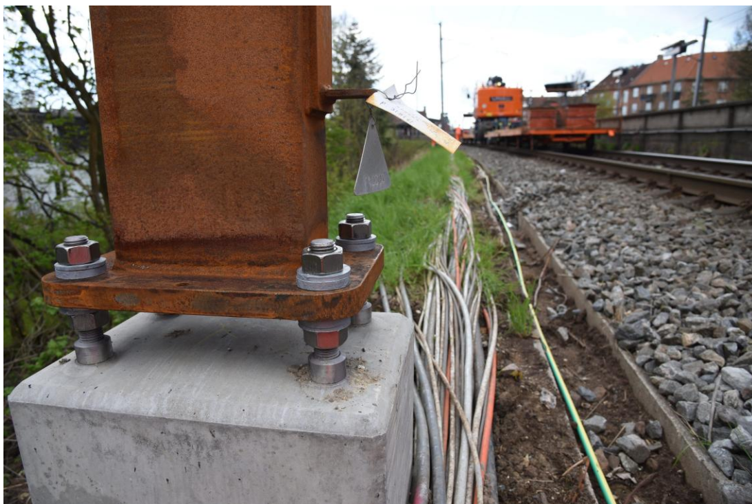
Abbildung 8: Abstandsmontage eines Oberleitungsmastes.
