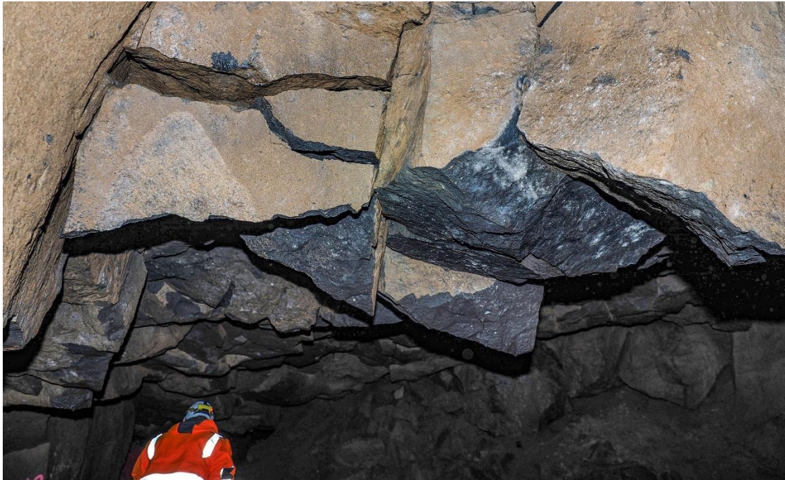
Abbildung 4: Stark aufgelockerte Firste mit Absenkungen und Bewegungen im cm-bis dm-Bereich entlang horizontaler und vertikaler Trennflächen (Foto vom 23.06.2020, A. Wehinger).
