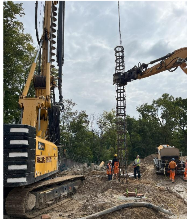
Abbildung 7: Einbau des Bewehrungskorbes.
