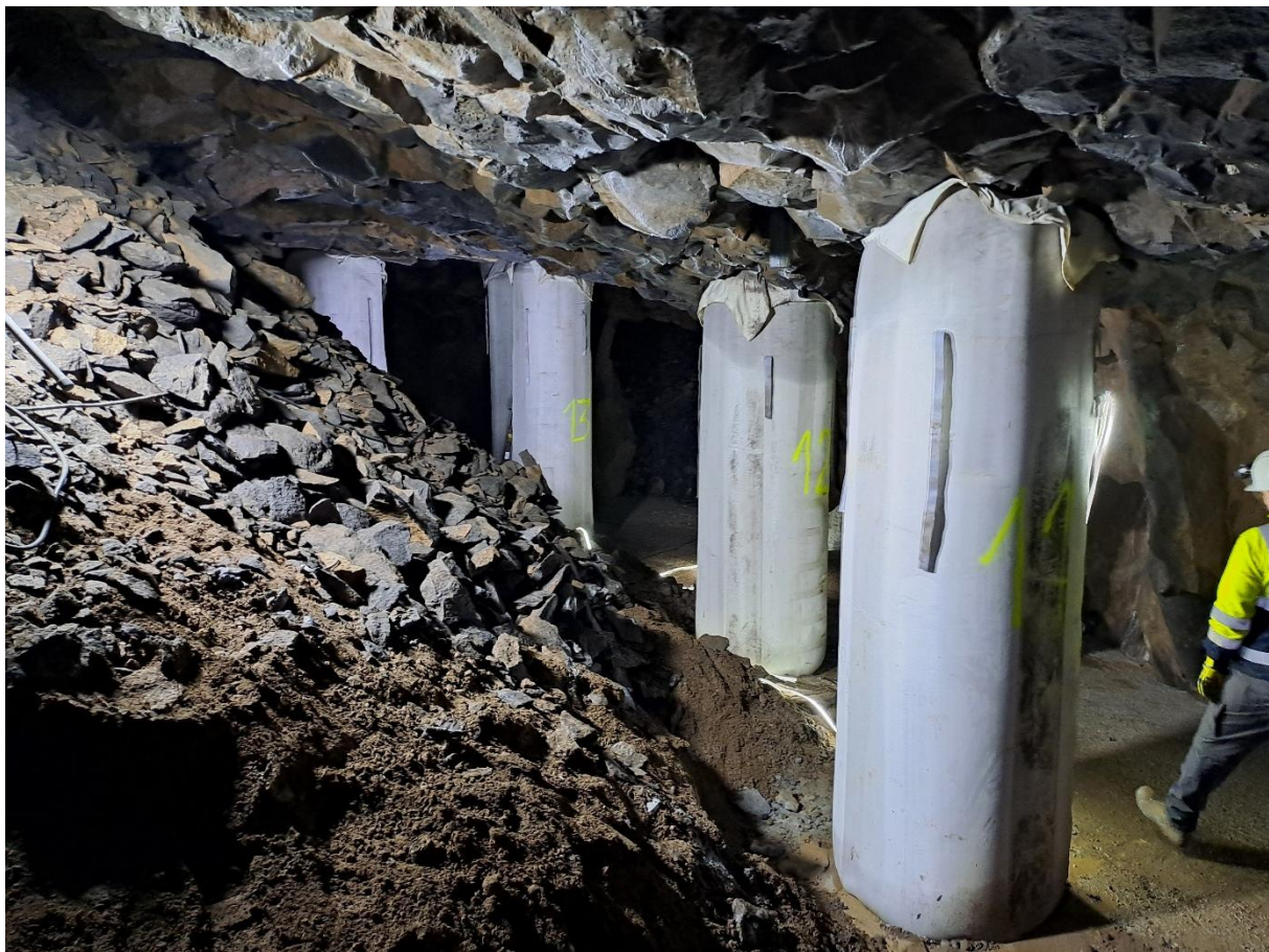
Abbildung 5: Bergmännisch hergestellte Gewebeschlauchpfeiler (System Bullflex®) unter einer öffentlichen Verkehrsfläche mit aufgelegten Bullflex®-Kissen zur Nachverpressung und Wiederherstellung des Kraftschlusses bei eventuell auftretenden Setzungen.
