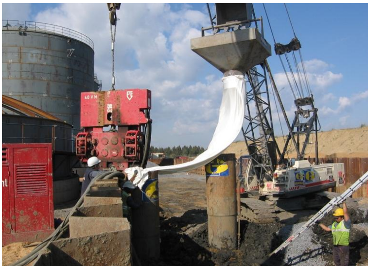
Abbildung 6: Geokunststoffummantelte Säulen (GEC): a — während des Einbaus; b — nach dem Aushub der oberen 4–5 m einer Säule.
