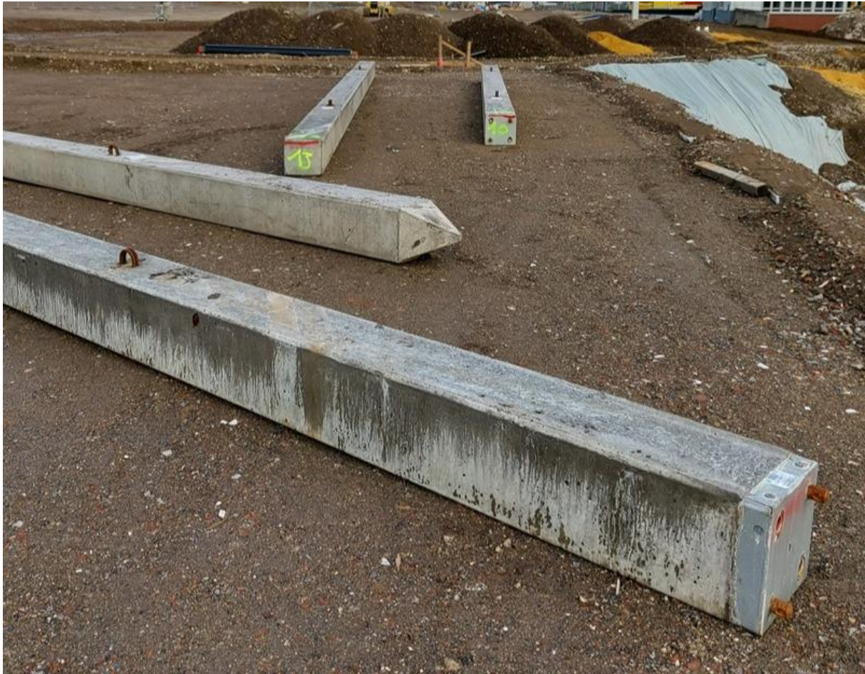
Abbildung 11: Fertigrammpfähle mit anbetonierter 60°-Spitze.
