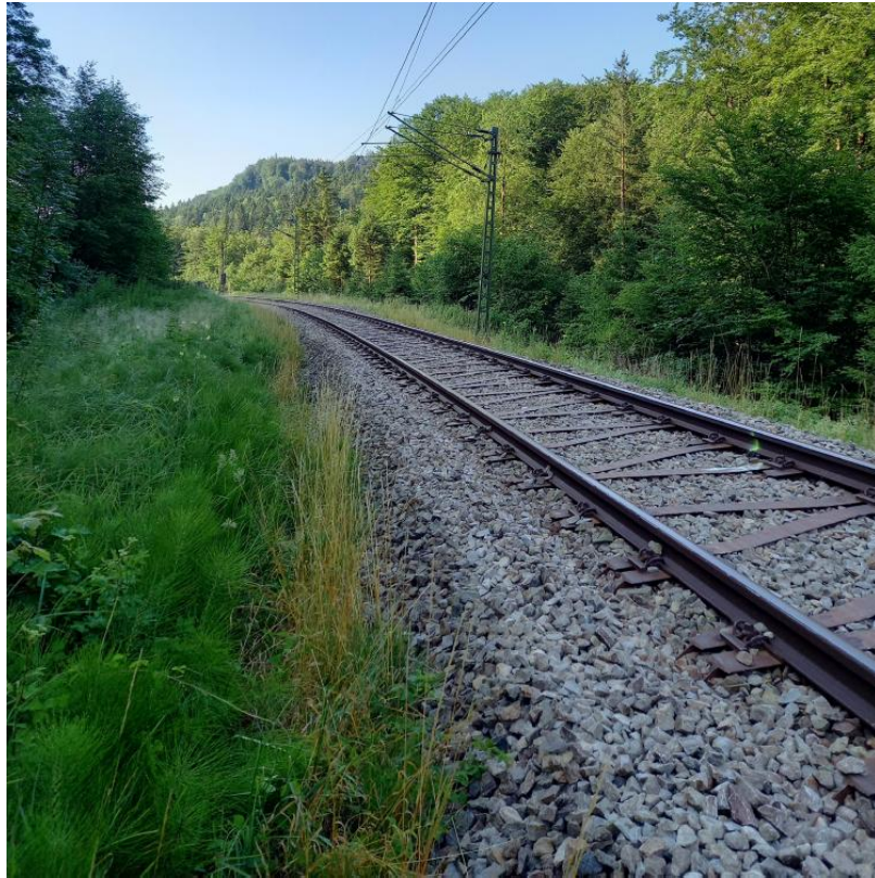
Abbildung 2: Obere Vernässungszone mit charakteristischem Ackerschachtelhalm-be-wuchs neben dem Gleis.
