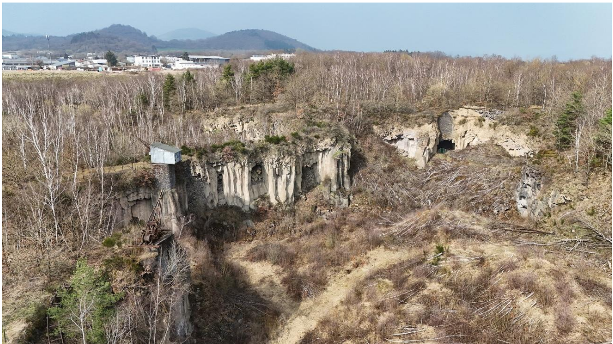
Abbildung 1: Luftbild mit Anschnitt alter Tiefbaue im Mayener Grubenfeld nördlich der Straße am Layerhof. Die Tiefbaue sind zum Teil mit Kleinschlag aus Basalt verfüllt. Im Vordergrund ist ein aufgelassener Tagebau vorhanden. Im Hintergrund sind der Ettringer Bellberg (links) und der Büden (rechts) zu sehen. Von hier ist der Mayener Lavastrom nach Süden (zum Betrachter) ausgeflossen (Foto vom 25.03.2025, A. Wehinger).
