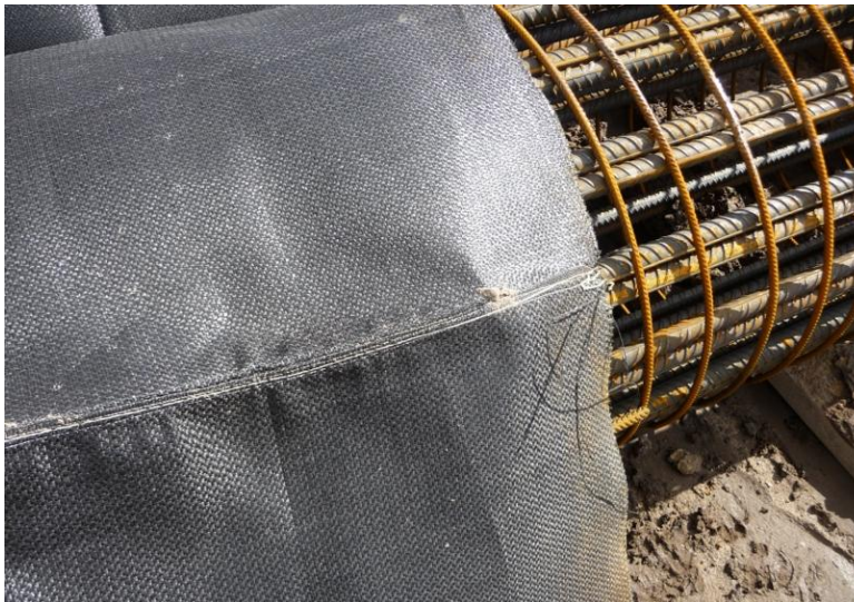
Abbildung 4: Genähte Geotextilummantelung: a — am Bewehrungskorb montiert; b — während des Einbaus in das Bohrloch.
