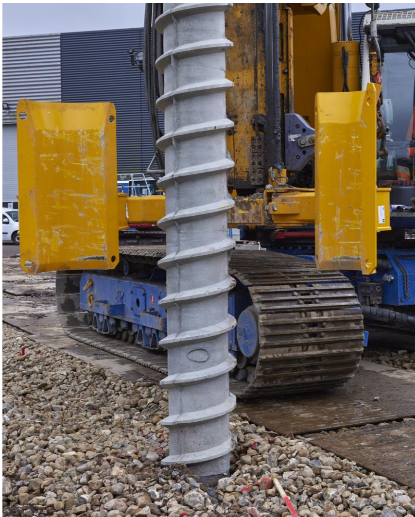
Abbildung 3: Fertigbetonschraubpfahl CPSP.
