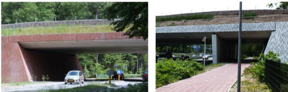
b. KBE nach der Verblendung mit Mauerwerk (passive Frontverkleidung)
