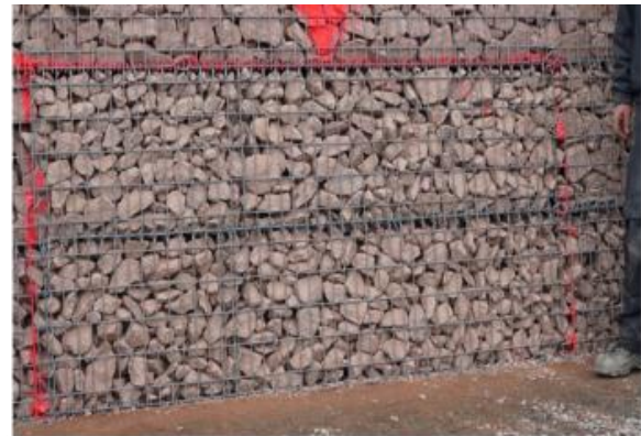
b. nach Sanierung
