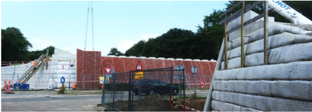
a. KBE in Umschlagmethode; Anbringen der Frontverkleidungen
