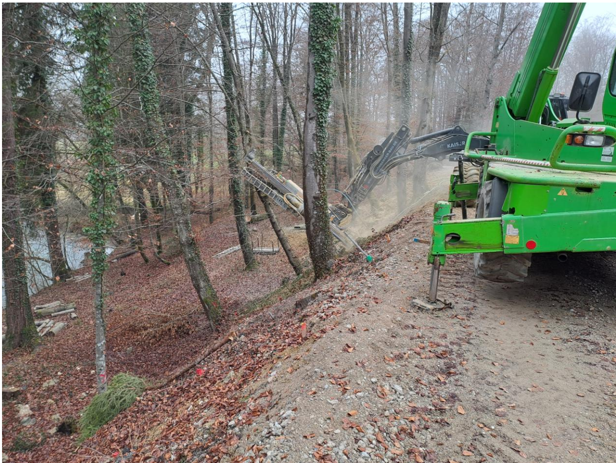
Abbildung 7: Einbau Mikropfähle von der Straße aus.
