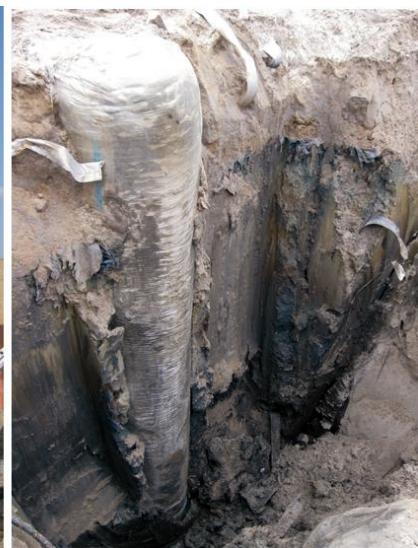
Abbildung 6: Geokunststoffummantelte Säulen (GEC): a — während des Einbaus; b — nach dem Aushub der oberen 4–5 m einer Säule.
