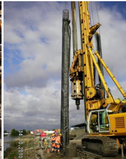
Abbildung 4: Genähte Geotextilummantelung: a — am Bewehrungskorb montiert; b — während des Einbaus in das Bohrloch.
