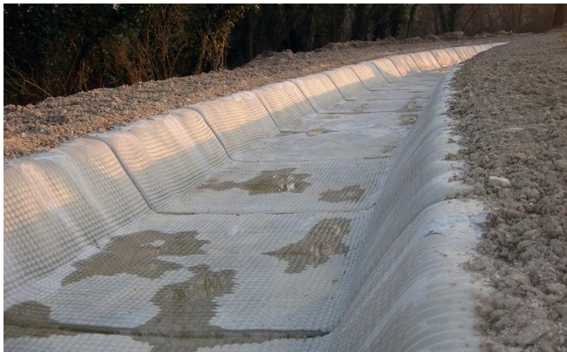
Abbildung 9: Wasserundurchlässige Betonmatte zur Kanalauskleidung (HUESKER).
