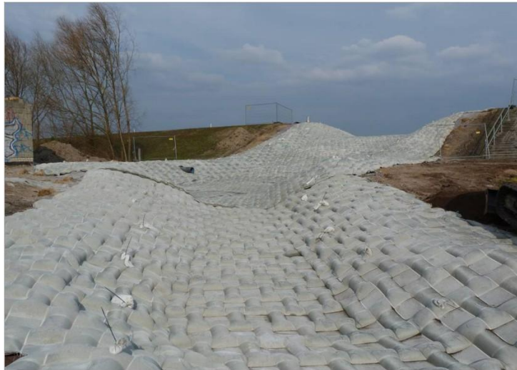
Abbildung 10: Wasserdurchlässige Betonmatte im Überströmungsbereich eines Damms (HUESKER).
