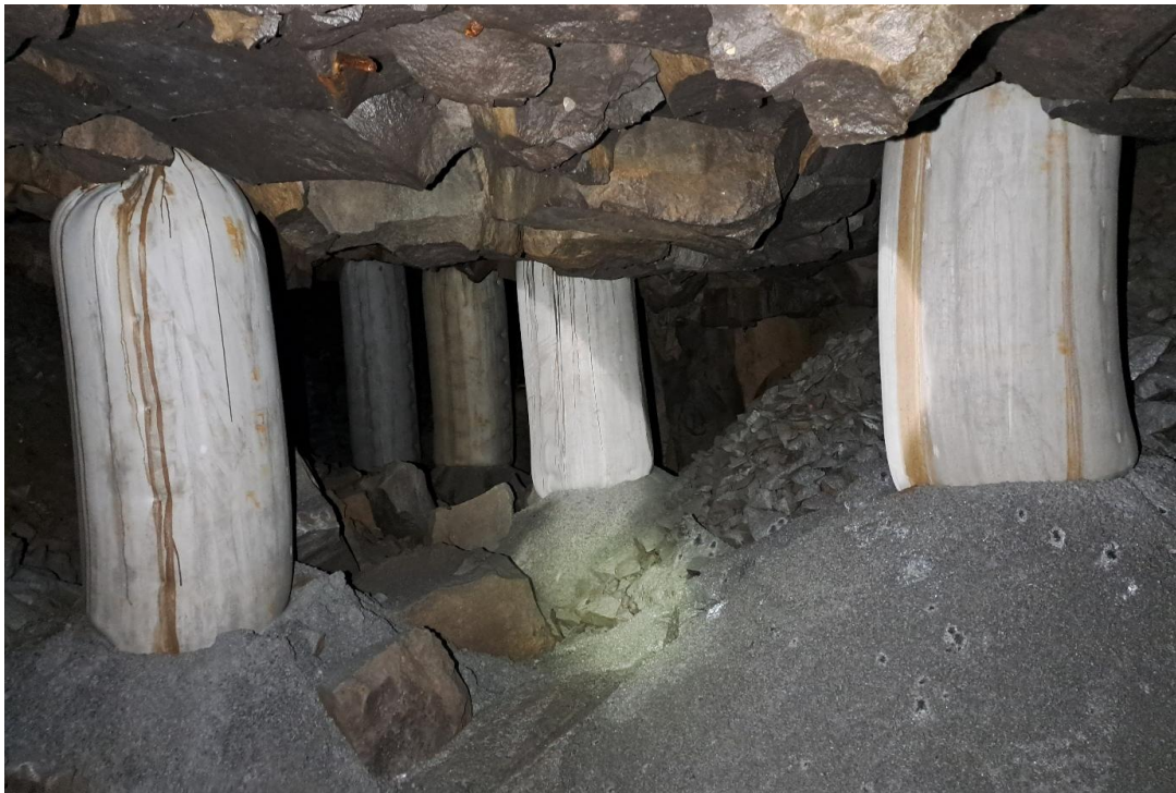
Abbildung 6: Bohrtechnisch hergestellte Bullflex®-Pfeiler auf zuvor geschütteten Gründungen aus vergütetem Basaltsplitt. Durchmesser der Pfeiler rund 1 m, Höhe zwischen 2 m und 3 m.
