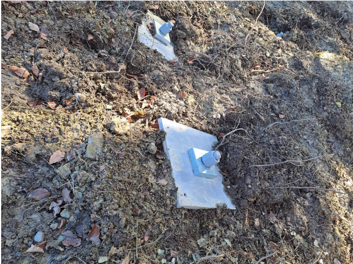
Abbildung 6: Eingebaute Mikropfähle mit Kopfplatte.
