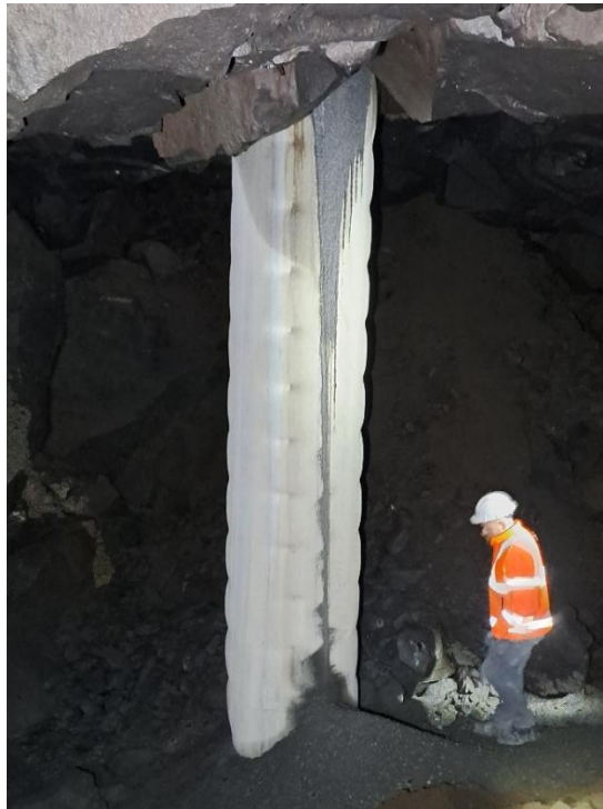
Abbildung 7: Rd. 5 m hoher, bohrtechnisch errichteter Bullflex®-Probepfeiler.
