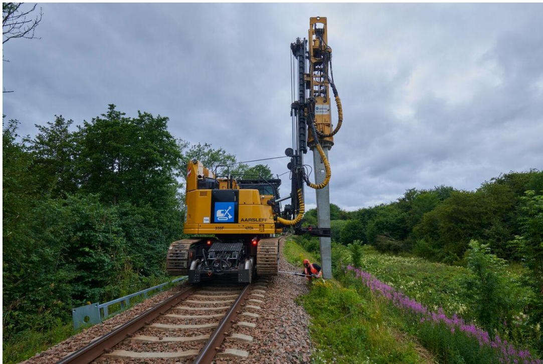
Abbildung 7: Einrammen eines Mastfundamentpfahles MFP.
